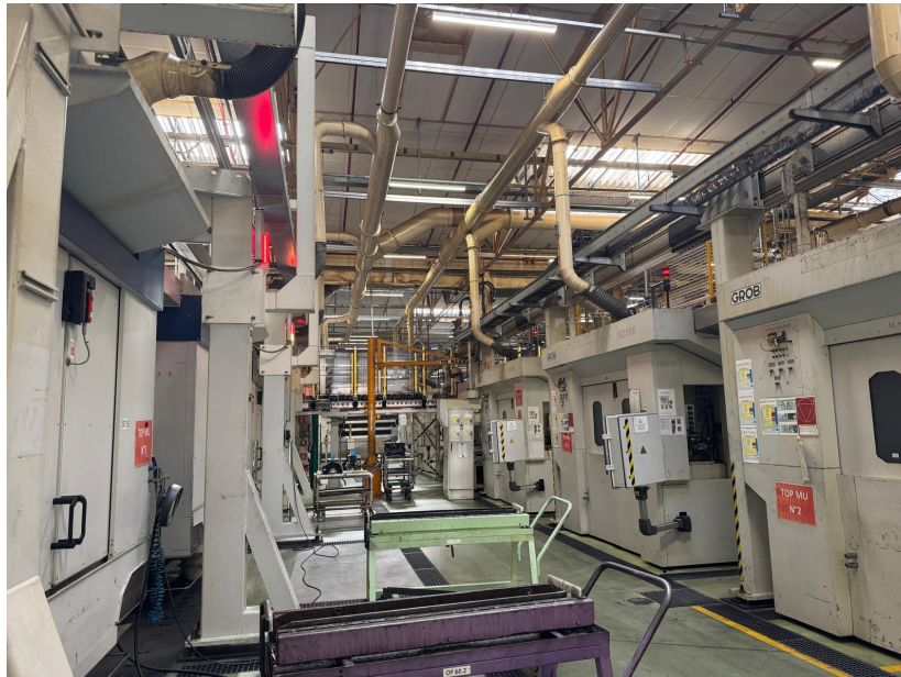
IMAGE 21. Une allée de l'atelier d'usinage de carters-cylindres, équipée de machines GROB (l'atelier compte plusieurs allées de ce type).
